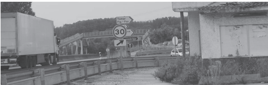
Figura 4 Estabelecimento comercial em ruínas que não resistiu às alterações que, naquele local do concelho de Condeixa-a-Nova, se efetuaram no IC2. A construção de lancis de separação afastou os potenciais clientes que, desta forma, foram impedidos de continuar a parar e frequentar aquele local.
