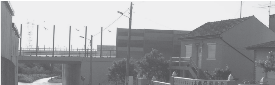
Figura 3 Casas de habitação confinadas pelo atravessamento de uma via rápida, no concelho de Condeixa-a-Nova. Como estratégia de atenuação de danos, nota-se o levantamento de uma barreira sonora e visual entre os espaços de residência e a rodovia.
