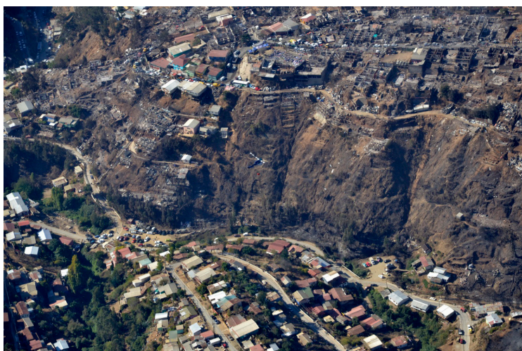
Figura 1.- Visión general de un sector afectado por el incendio de Valparaíso en abril de 2014. Se muestra la destrucción casi total en sectores de altas pendientes.
