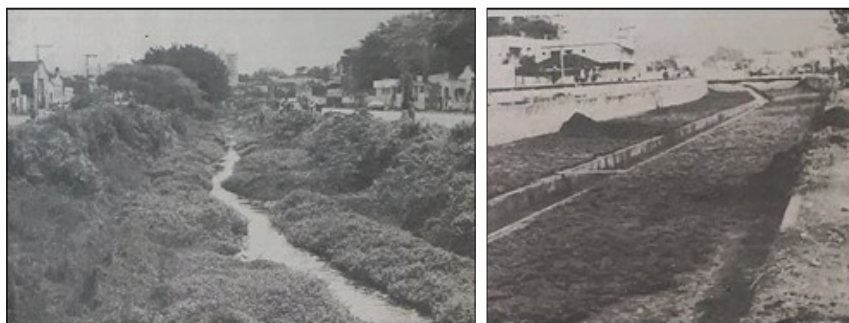
Fot. 31 - Canalização do Córrego do Lenheiro no bairro Tejuco, Rua Rossini Bacarini, 1990 (Fotografia de Tribuna Sanjoanense, 1991, p. 3).
