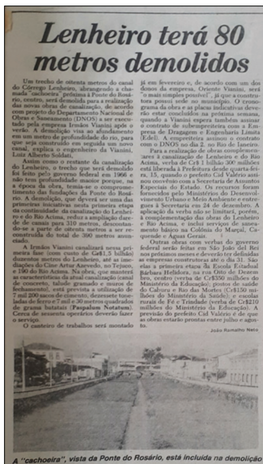
Fig. 47 - Lenheiro terá 80 m demolidos (Fonte: Jornal de São João Del Rey, 1986a, p. 3).
