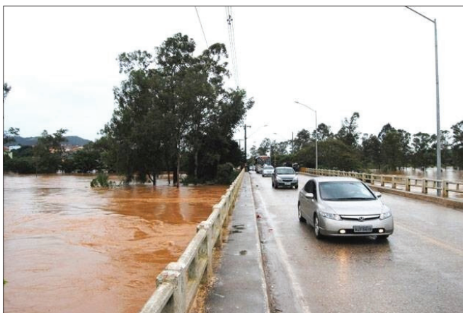
Fot. 13 - Ponte do Bezerrão (via de ligação entre a Avenida Leite de Castro e a Colônia do Marçal), 2012 (Fotografia de Eustáquio e Ribeiro, 2012, s.p.).
