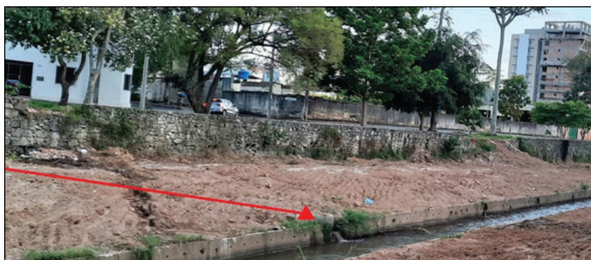
Fot. 40 - Possível desembocadura do Córrego do Dom Bosco (Fotografia do acervo de Fernanda Resende, 2022).
