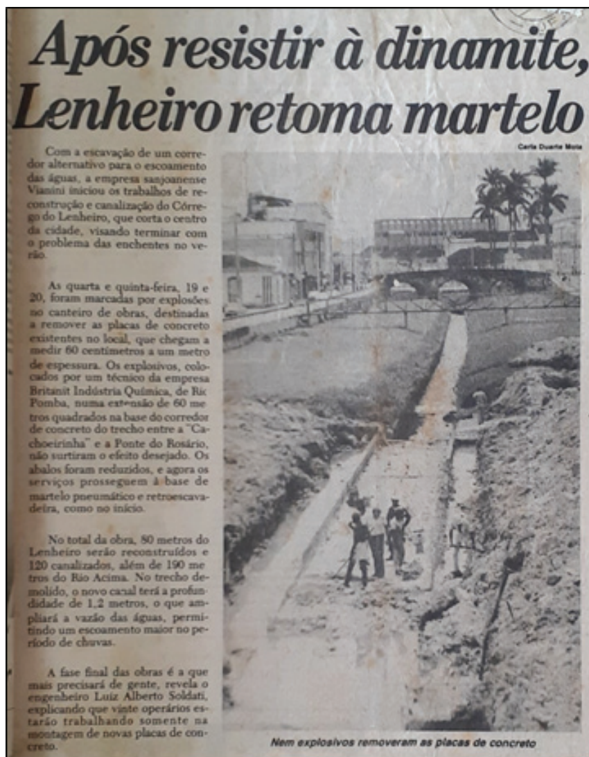
Fig. 48 - Demolição da canalização (Fonte: Jornal de São João Del Rey, 1986b, p. 1).
