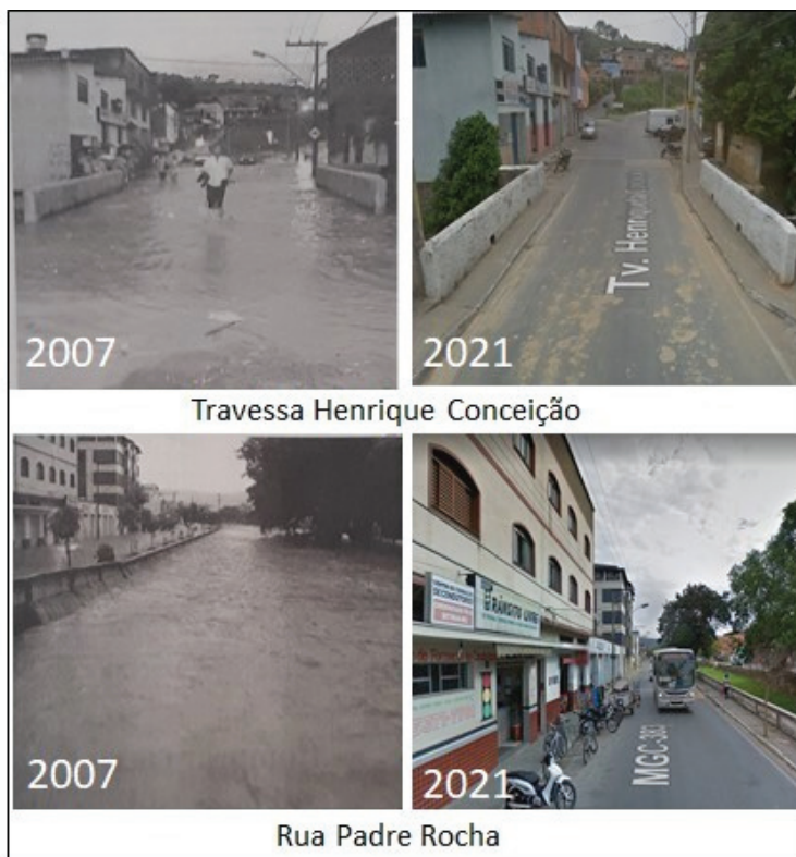
Fot. 11 - Inundação no Tejuco (Fonte: Ferreira et al., 2022, com base em Gazeta de São João del-Rei, 2007b, e em São João del-Rei, 2021).
