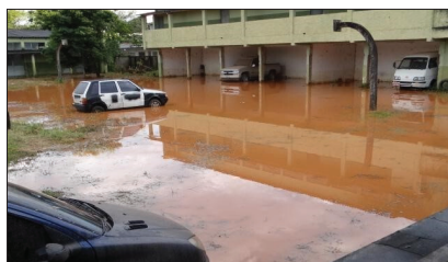
Fot. 17 - Escola Garcia de Lima (Fotografia de Defesa Civil de São João del-Rei, 2018b, p. 4).
