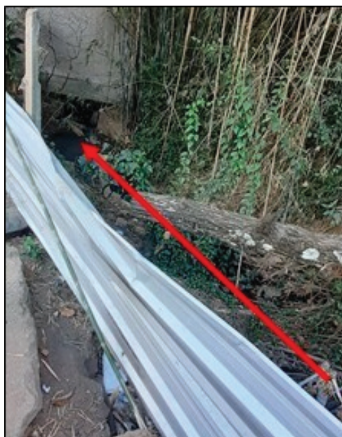
Fot. 36 - Casa sobre o Córrego da Caieira (Fotografia de Ferreira et al. , 2023a, p. 14).
