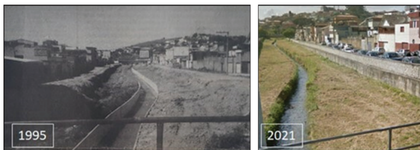
Fot. 32 - Trecho canalizado do Córrego do Lenheiro entre ruas Antônio Josino de Andrade e Aldo Zerlotine, 1995/2021 (Fotografia adaptada de Tribuna Sanjoanense , 1995, p. 1).
