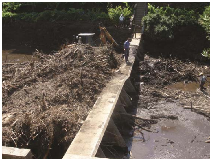
Fotografia 7. Acumulação de materiais, na ponte da Vide.
