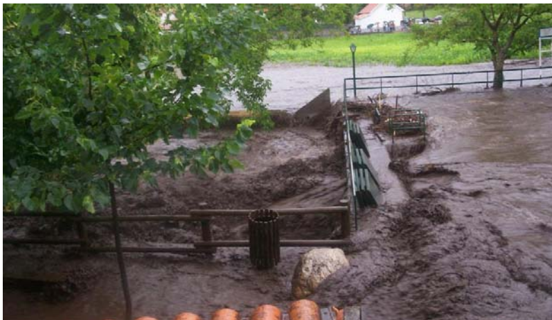
Fotografia 5. Aspeto da ponta de cheia no dique de suporte das comportas da praia fluvial de Pomes, as quais são visíveis sobre ele.
