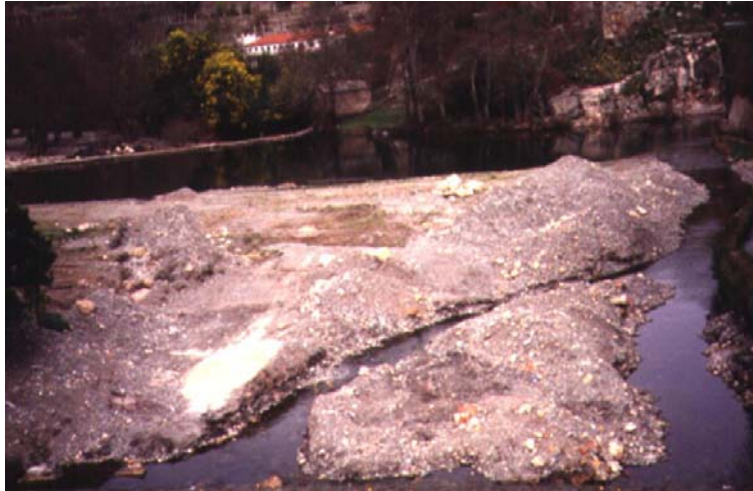
Fotografia 13. Vista geral, em primeiro plano, do que restou da praia fluvial de Avô, após a enxurrada, uns dias depois do acontecimento. À direita, o inofensivo caudal da ribeira de Pomares, mas que dias antes foi responsável pelo sucedido.
