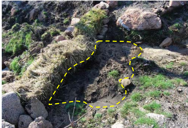
Fotografia 8. Acumulação de sedimentos na barreira de fardos de palha (limite pela linha tracejada).
