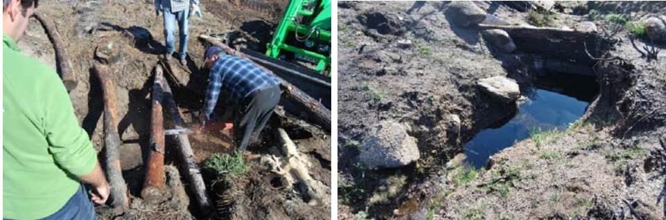
Fotografias 4A e 4B. Construção de barreiras de troncos.
