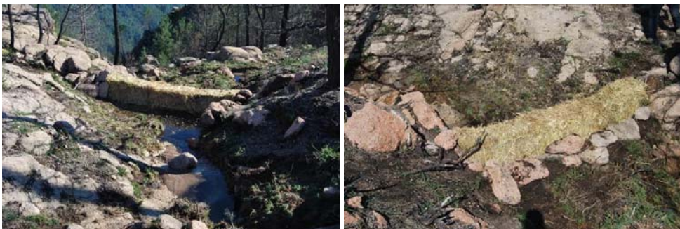
Fotografias 5A e 5B. Barreira de fardos de palha.
