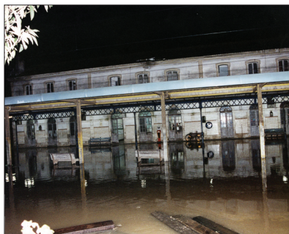
Fot. 7 - Cheia de 27 de janeiro de 2001: Inundação da estação de caminhos de ferros de Alfaiolos (Fotografia cedida pela Foto Martins)
