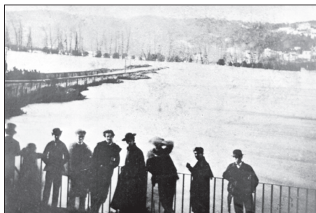
Fot. 1 - Ponte de Santa Clara parcialmente submersa por uma cheia do Mondego em finais do séc. XIX (CMC/Imagoteca, 189?).
