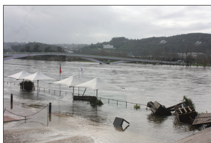
Fot. 8 - Cheia de 13 de fevereiro de 2016: Parque Verde do Mondego, destruição dos bares e restaurantes das docas (Fotografia de João Pardal, 13 de Fevereiro de 2016).
