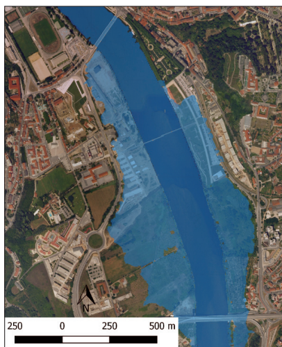
Fig. 11 - Inundação verificada para um caudal superior a 1400 m 3 /s (Fonte: J. Vieira et al. , 2016).
