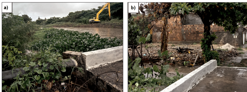
Fot. 2 - Registro da área de estudo sobre a ponte do rio Cuiá, ligando a rua Francisco Porfírio Ribeiro, no Bairro de Mangabeira à rua Brasilino Alves da Nóbrega, no Bairro do Valentina: (a) retroescavadeira desassoreando a margem direita à jusante da ponte; (b) terreno localizado na margem esquerda a montante da ponte (Fotografia de Maria Alves, tirada a 13/02/2019).
