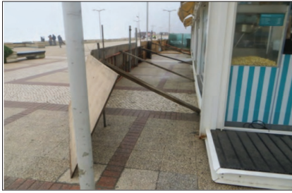
Fot. 4 - Proteção com taipais frente a um café, na expectativa de ocorrência de galgamentos oceânicos na esplanada marginal (Foto: Campar de Almeida, 2017).
