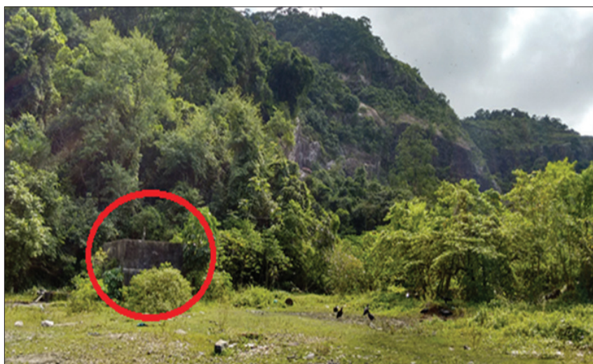
Fot. 2 - Instalações abandonadas na Pedreira do Horto (Fotografia de Bérgamo, tirada a 28/02/2021).
