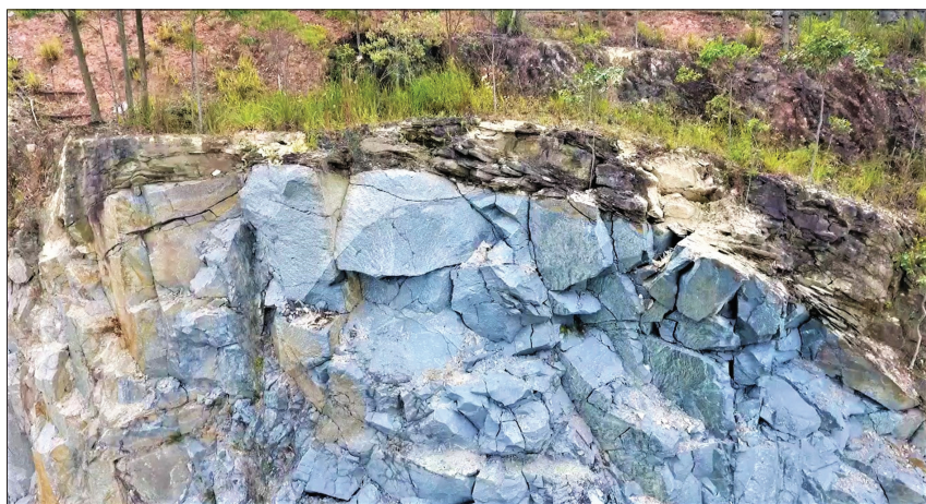
Fot. 3 - Fraturas de alívio de tensões em camada de rocha alterada (Fotografia de Jehovah Nogueira Jr., tirada a 05/02/2018).
