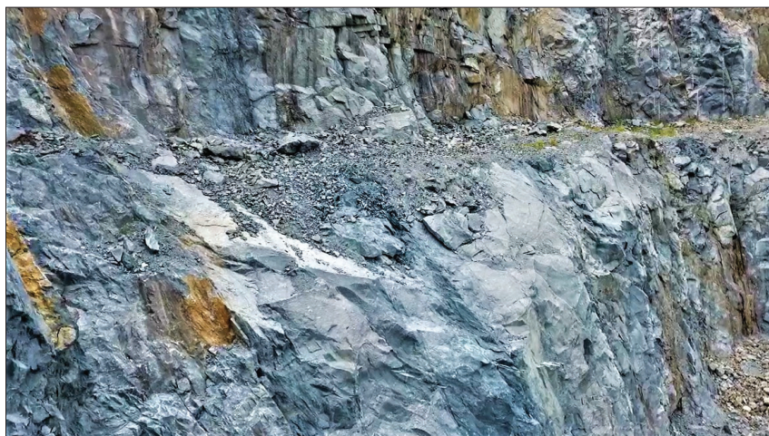
Fot. 4 - Superfícies de fraturas com mergulhos desfavoráveis (Fotografia de Jehovah Nogueira Jr., tirada a 05/02/2018).
