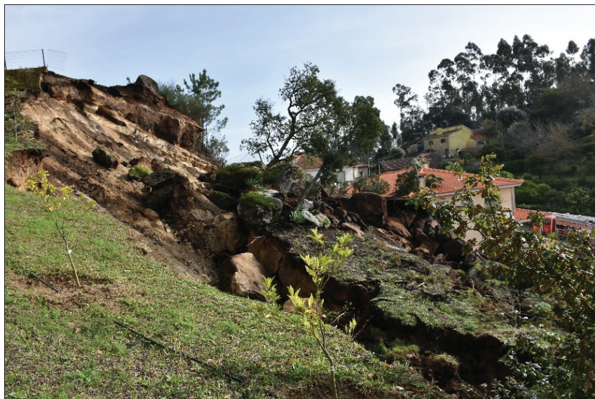
Fot. 4 – Superfície de deslizamento aproveitando descontinuidade no maciço granítico. Observa-se o material suprajacente movimentado, ainda mantendo a sua estrutura geral original (Fotografia de António Vieira, tirada a 23/11/2022).
