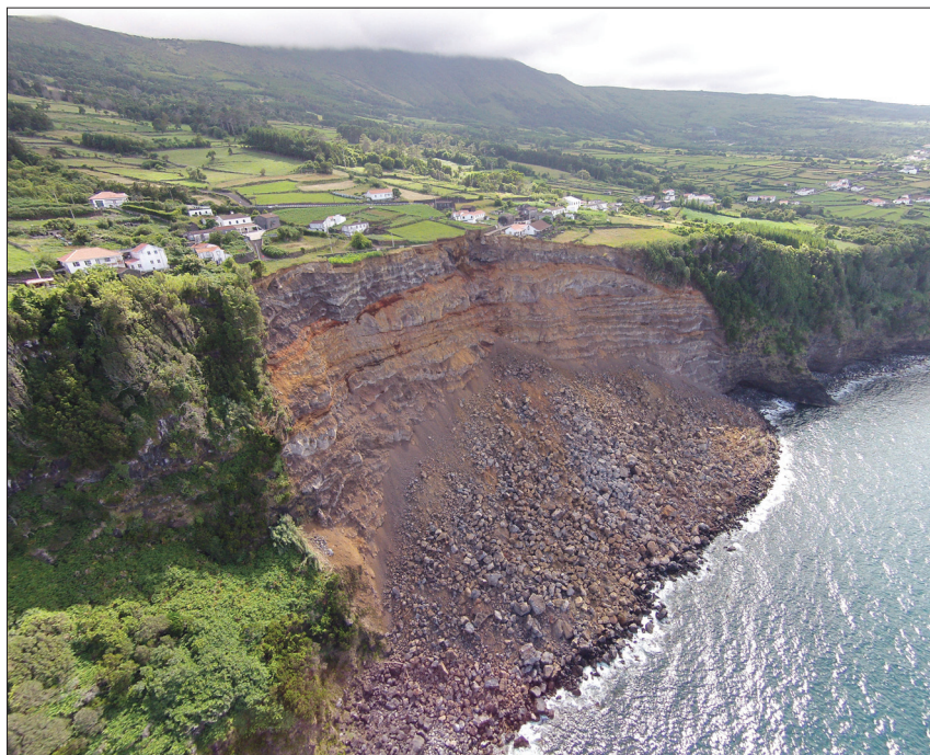
Fot. 10 - Vista geral da cicatriz no final do processo de instabilização (Fotografia de Diogo Caetano, tirada a 09 de julho de 2014).
