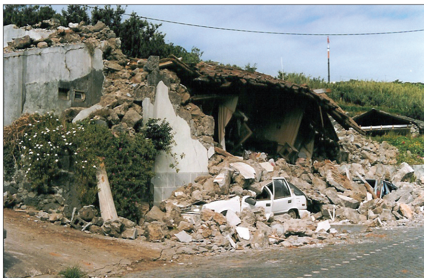
Fot. 1 - Muitas casas sofreram danos devido à má construção e à proximidade a falhas tectónicas (Fotografia de LREC-Açores, tirada em julho 1998).
