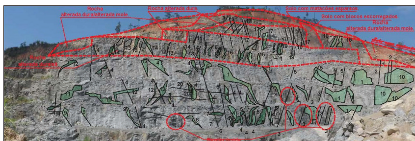
Fig. 3 - Mapeamento de talude rochoso.
