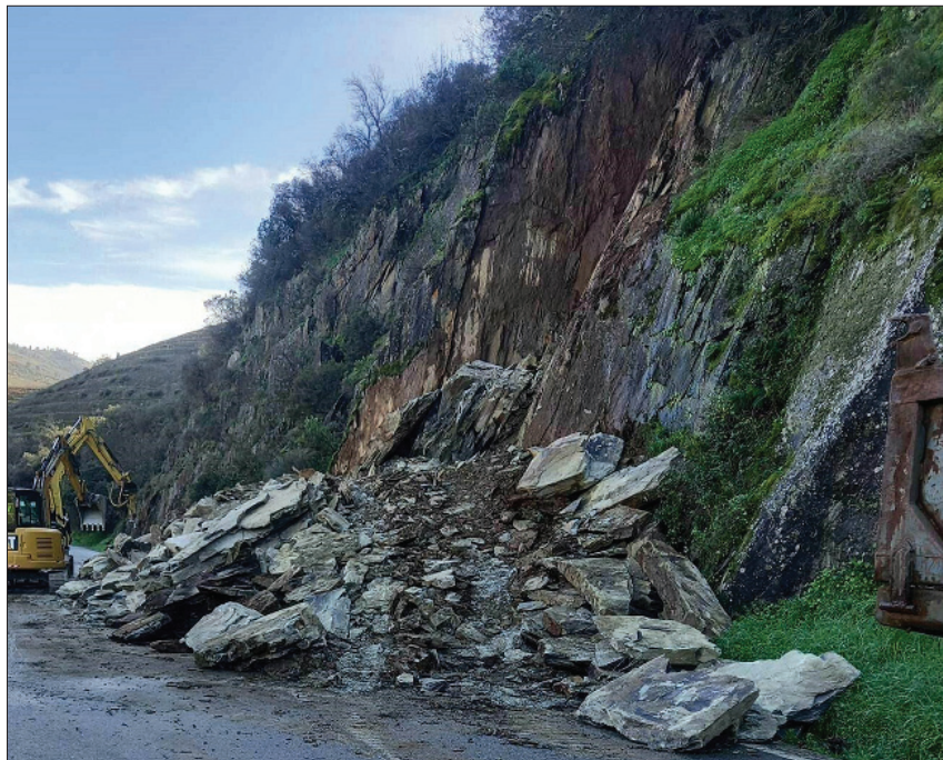
Fot. 2 - Rotura da superfície de suporte e colapso.
