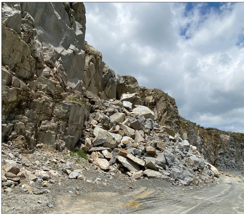
Fot. 5 - Escorregamento associado a fraturas subverticais (Fotografia de Jehovah Nogueira Jr., tirada a 12/03/2022).
