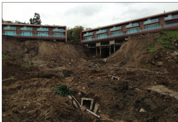
Fot. 2 - Moradias afetadas, podendo ver-se a estacaria em que estavam assentes, e volume de detritos provenientes do deslizamento, que se acumularam na variante Guimarães-Fafe (Fotografia de Câmara Municipal de Guimarães, tirada a 03/04/2013).
