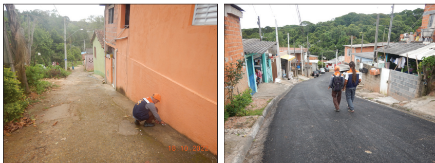
Fot. 2 - Trabalho de campo na área de estudo para coleta de informações de declividade (inclinação da via/trecho: A) Exemplo de via pavimentada com concreto, em área de expansão urbana pouco/média consolidada e sistema de drenagem ausente; B) Exemplo de via pavimentada com asfalto, em área urbana consolidada e sistema de drenagem precário (Fotografia de Paulo Leal / Acervo IPA, tirada em 18/10/2022).
