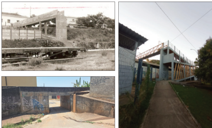
Fot. 6 - Passarela para pedestres e pontilhão de passagem para veículos (Acervo Pessoal).
