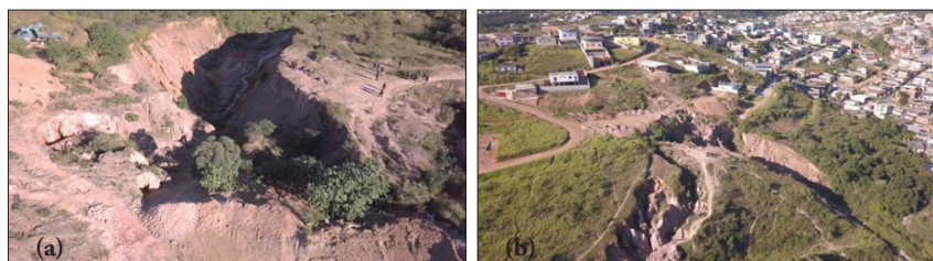
Fot. 1 - Detalhe da voçoroca (a); Visão panorâmica do processo erosivo (b) (Fonte: Levantamento em campo, 2019).
