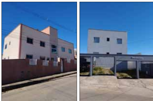
Fot. 1 - Edificações de dois pavimentos novos, no entorno da E. M. Walfrido Silvino dos Mares Guia (Fonte: Acervo dos autores, 2023).
