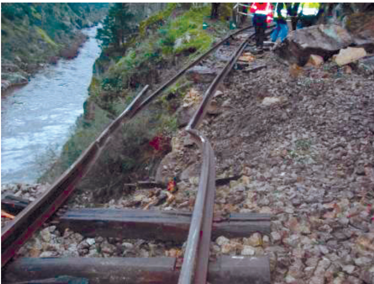
Fot. 3 - Aspeto dos carris após o acidente (Autora: Maria Gouveia, 2007). Photo 3 - Rails' appearance after the accident (Author: Maria Gouveia, 2007).
