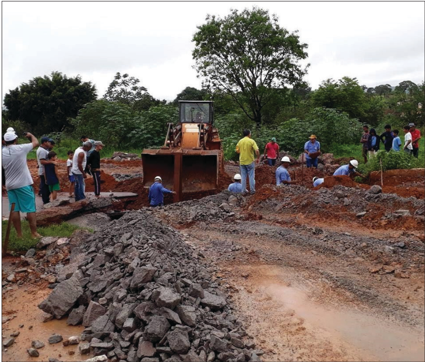
Fot. 2 - Processo de aterramento da dolina na Avenida Geraldo Campos, Bairro Vazante Sul, Vazante (MG), 2018 (Fonte: Rádio Montanheza, 2018).
