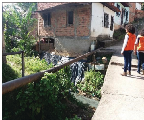
Fot. 2 - Área sem infraestrutura e saneamento básico (Vila Embratel, São Luís, MA, Brasil) (Fonte: Arquivo de pesquisa, 20/07/2018)
