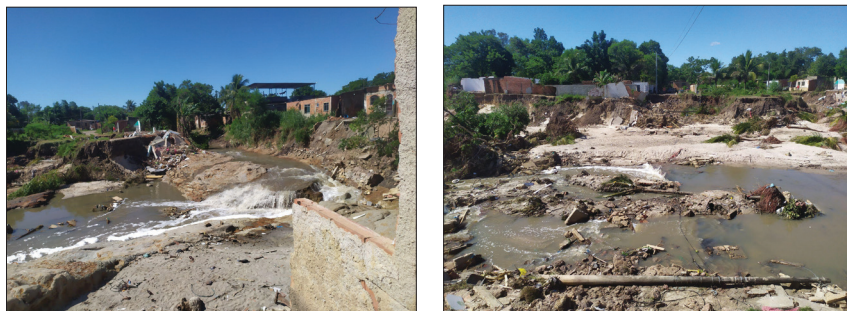
Fot. 1 - Destruição causada pelas chuvas em Abril de 2022 (Fonte: Acervo pessoal).
