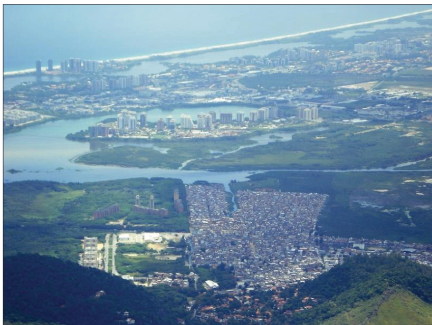
Fot. 2 - Visão da favela do Rio das Pedras e sua condição de risco (Fotografia do autor, tirada a 8 de janeiro de 2008).
